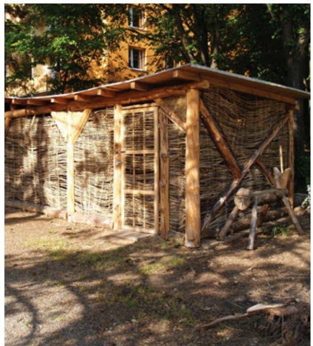
Kmene z vyrúbaných stromov zo záhrady vo Waldorfskej základnej a materskej škole v Brne boli využité na nosnú konštrukciu záhradného domčeka. Žiaci 1. a 2. stupňa sa postupne podieľali na stavbe záhradného domčeka a krytej pergoly - prepletaním stien prútím, šliapaním hliny do správnej hustoty, nanašaním hliny na steny a záverečnou výzdobou prírodnými farbami.
