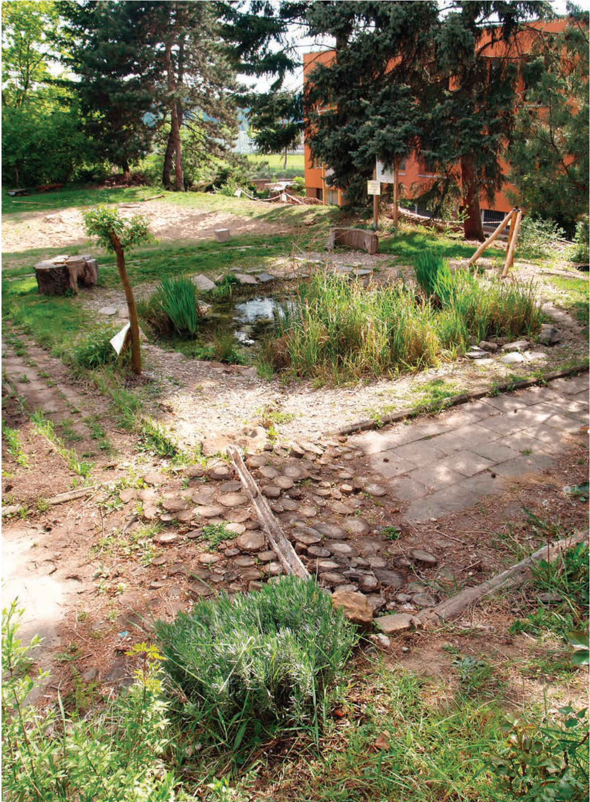
Pozorovací jezírko je doplňováno dešťovou vodou pomocí korýtka v propustném chodníčku.
