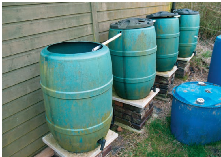
Propojené sběrné sudy umožní ze zahradního domku nasbírat více dešťové vody.
